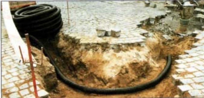
Rohrverformung infolge Erdlast und Verkehrslast SLW 60 bei Einbau in G2, 95% DPr
